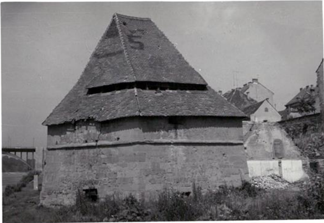
Vodni stolp 1.1967 - pričetek rušenja stavb okrog Vodnega stolpa
