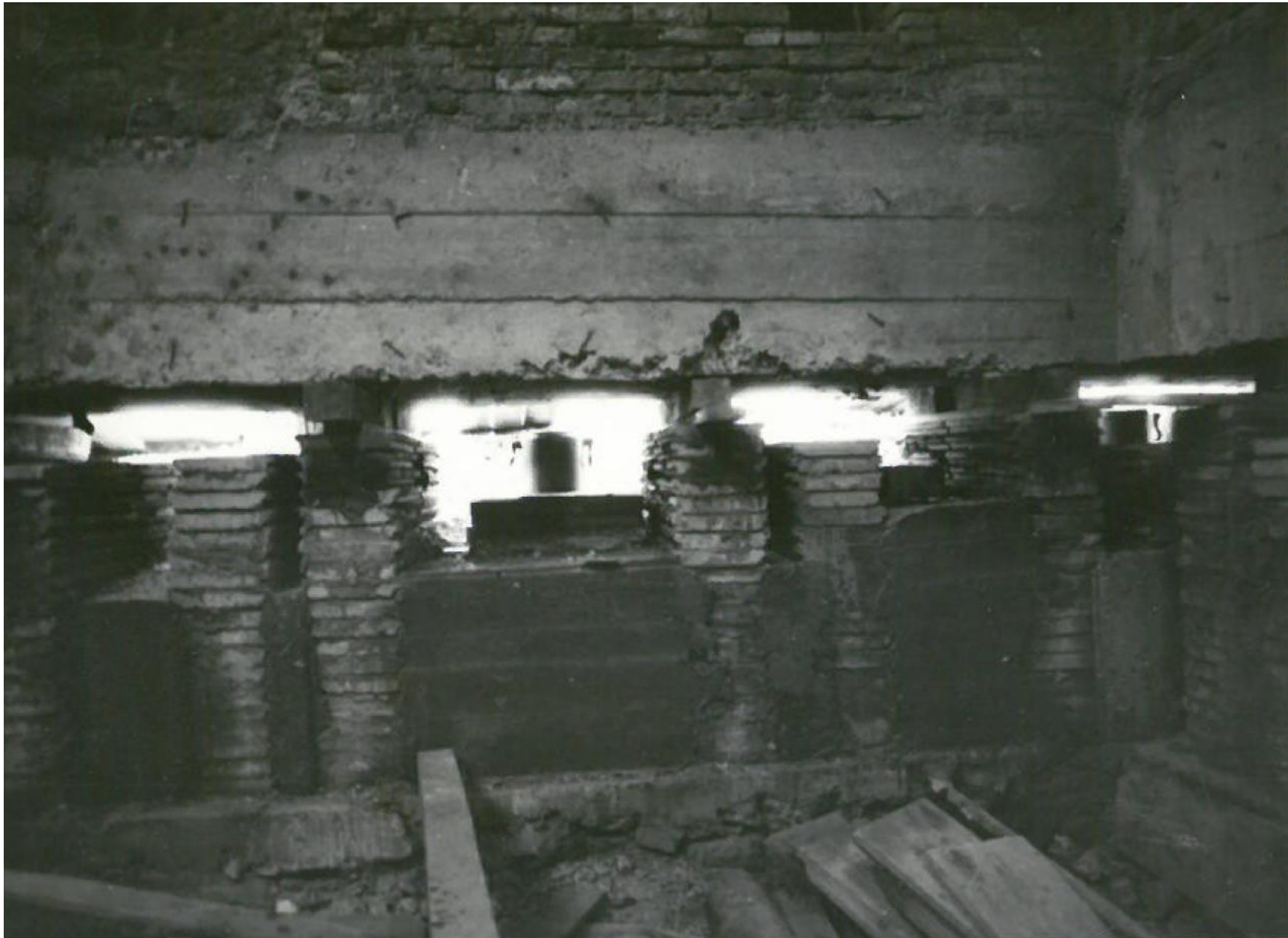
Dvig Vodnega stolpa, 1967-1968, fototeka ZVKDS OE MB
