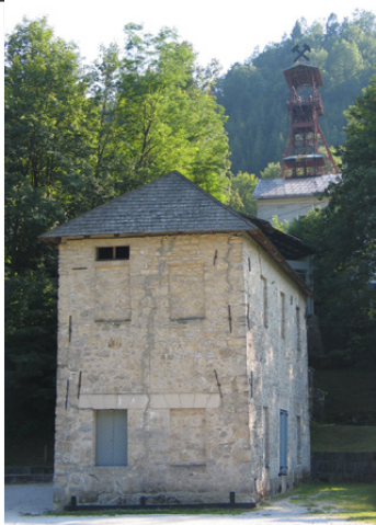
Idrija Vodna črpalna naprava Kamšt
