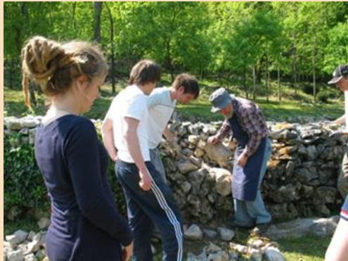
Delavnica suhozidne gradnje v Braniku, 2010
