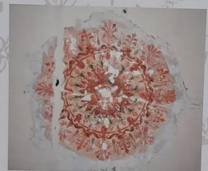
Ijubljana, Mestni trg 16, stropna roseta, ki je nastala verjetno ob koncu 18. stol. ima šablonsko osnovo, zaključna obdelava pa je izdelana ročno.
