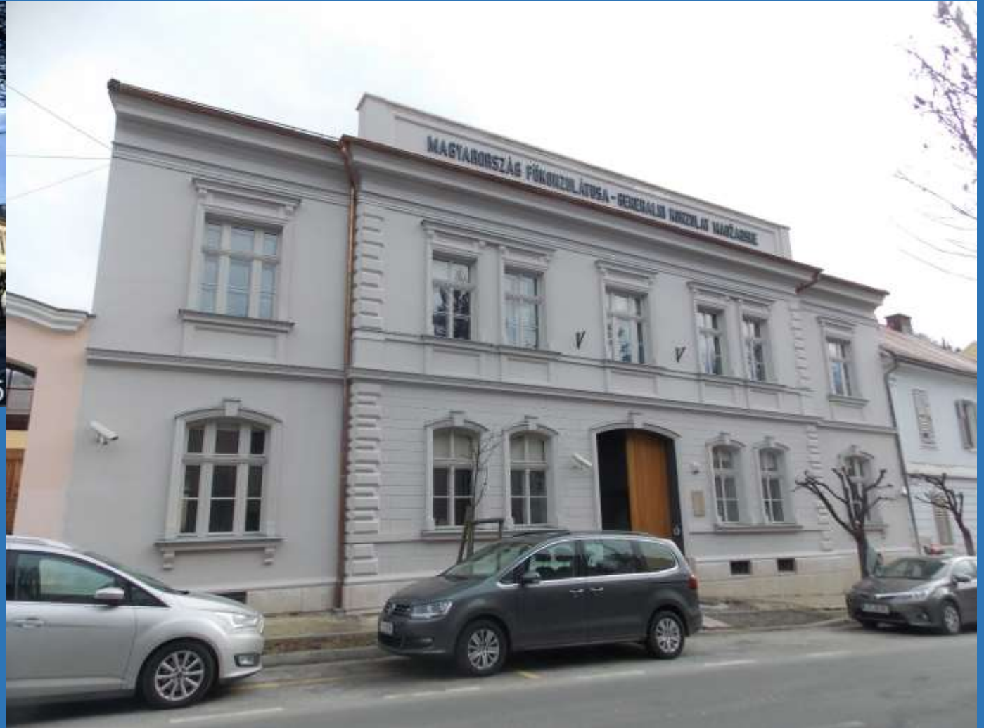
Lendava – Glavna ulica 30 (madžarski konzulat, po obnovi)
